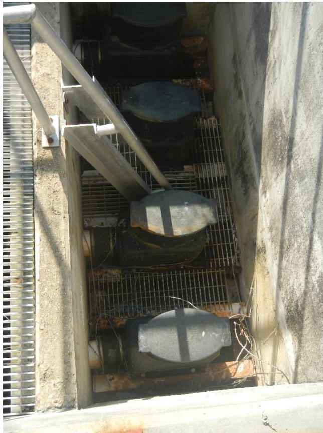
Photo 5. Effluent chlorinators.
