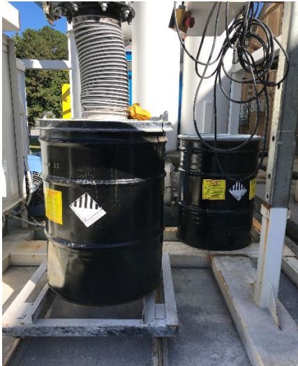
Photo-5 Baghouse SAA 1
