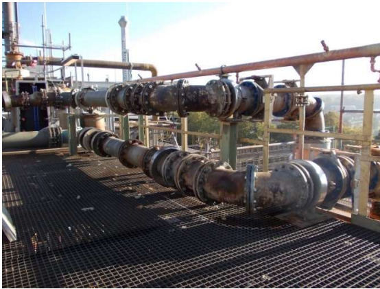
Früher: Stahl m. Inliner
