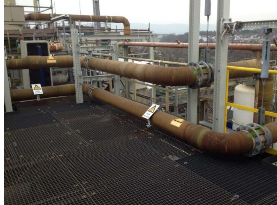
Heute: GfK mit geschweißtem Inliner
