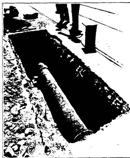
COURTESY U. S. PIPE & FOUNDRY CO.
