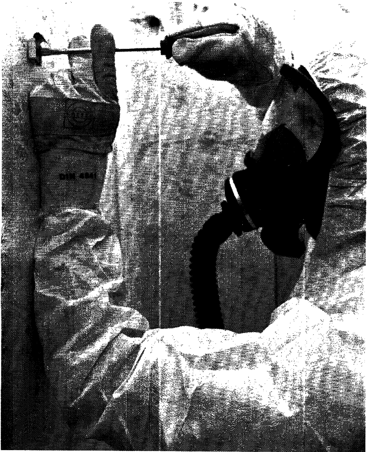
Sanierung oder Abriss asbestbelasteter Gebäude ist aufwendig. Nur mit Schutzanzug und Atemschutzmasken sollten sich Arbeiter in den „Schwarzzonen“ bewegen. Leider sieht die weitverbreitete Praxis – schon aus klimatischen Gründen – oft anders aus.
