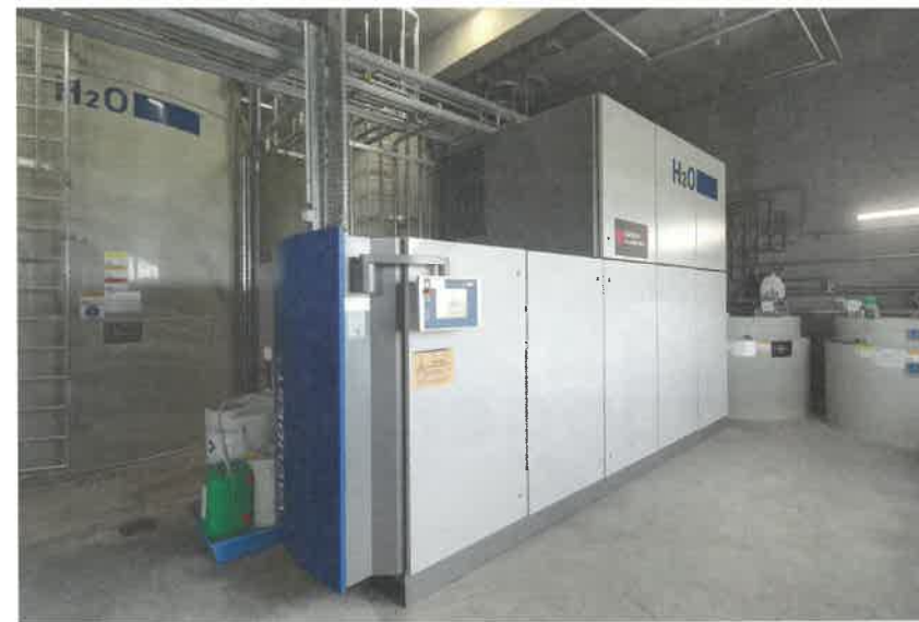
Saubere Aufbereitung in einem Schritt mit den Vacudest-Vakuumdestillationsanlagen
