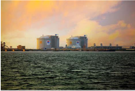
Picture 1: LNG Terminal
